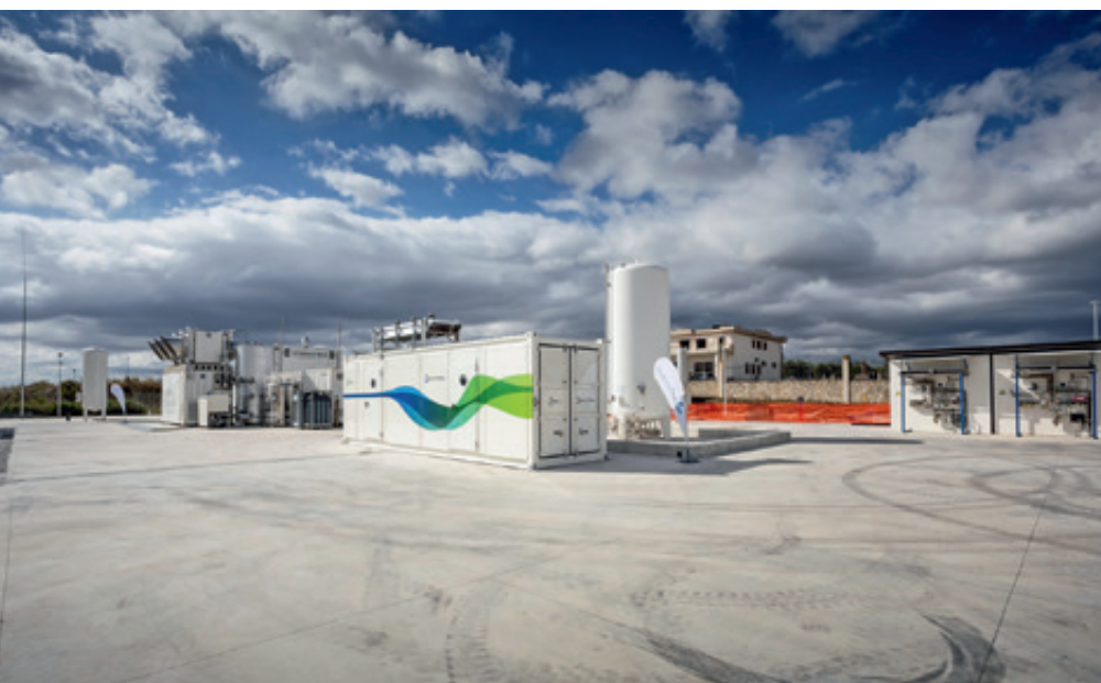
Abb. 3: Die Demoanlage im italienischen Troia kombiniert einen neuartigen Mikroreaktor für die Methanisierung mit einer innovativen Verflüssigungsanlage; das erforderliche \text{CO}_2 wird aus der Umgebungsluft gewonnen.
