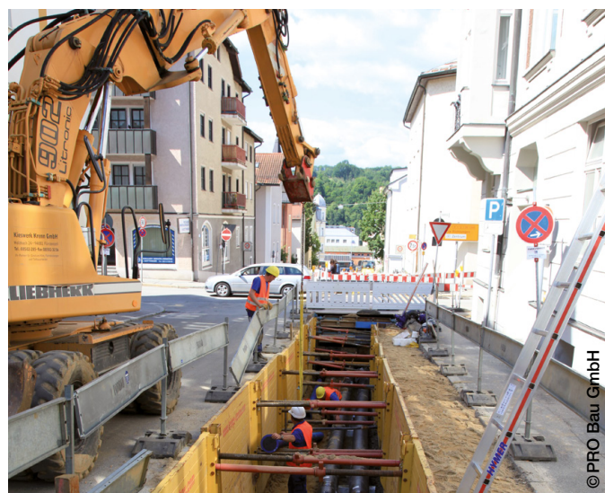
Abbildung 8 Langfristige Versorgungssicherheit erfordert kontinuierliche Instandhaltung
